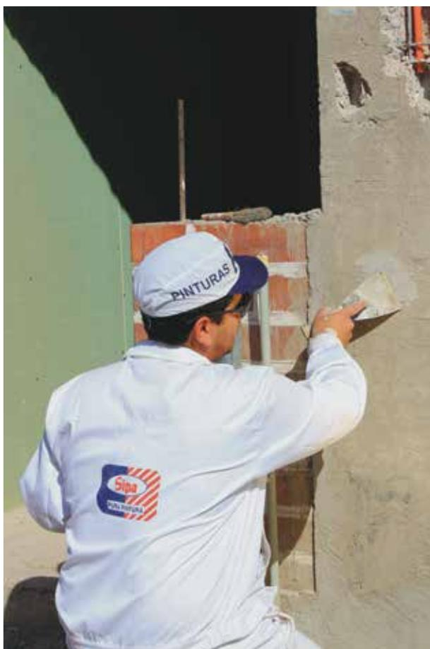
**Características y usos:** Pasta de naturaleza sintética, que al mezclarse con cemento y agua, genera un mortero de mediana capacidad de relleno, para enlucir, maquillar, y mejorar las superficies estucadas; aplicable en espesores menores a 1.00 mm.
