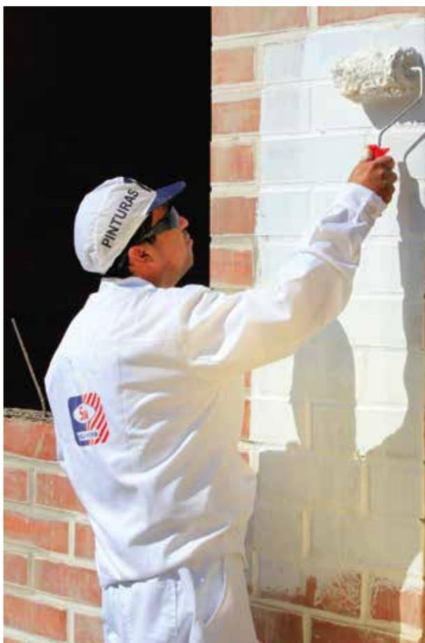
**Características y usos:** Producto de terminación mate, formulado con resinas sintéticas modificadas base agua, de alta resistencia sobre sustratos alcalinos, que funciona como puente adherente para las Texturas, Látex y Esmaltes, además se usa para sellar antes de colocar el papel mural.
