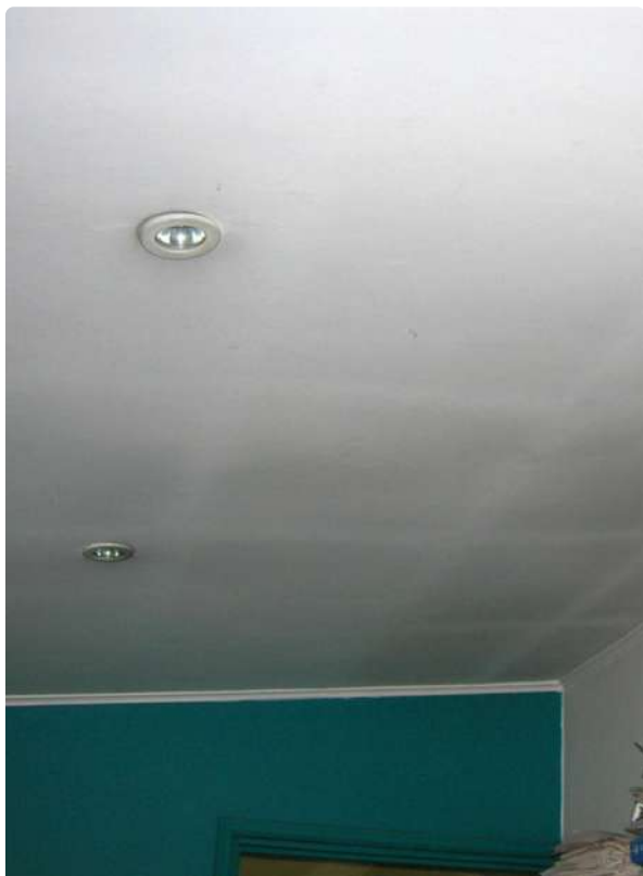
MANCHAS CAUSADAS POR "SMOG" DOMÉSTICO EN LOS PUENTES TÉRMICOS, SE PUEDEN CUBRIR CON ÓLEO OPACO.
