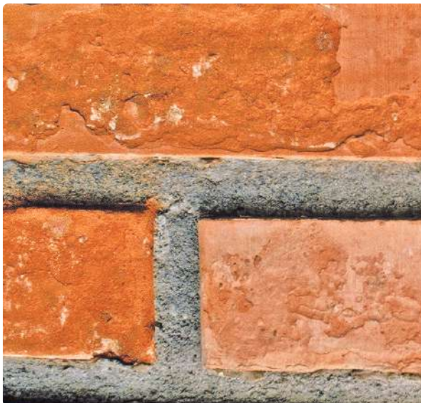
LADRILLOS DAÑADOS POR HUMEDAD Y HELADAS, POR NO HABER SIDO PROTEGIDOS CON SILICONA HIDROFUGANTE.
