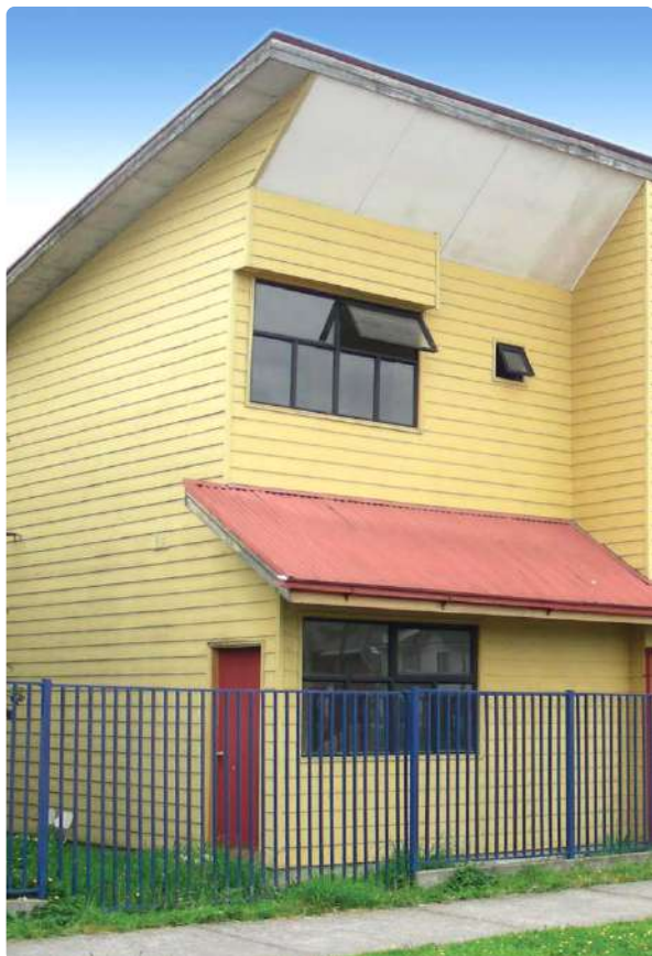
ESMALTE AL AGUA SOBRE SIDING DE FIBROCEMENTO.
