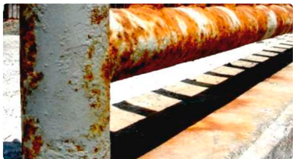
CORROSIÓN CERCANA AL MAR, IQUIQUE, PROVOCADA POR UNA ATMÓSFERA NÍTRICA DE LAS GUANERAS.
