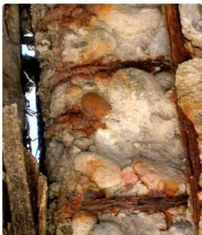
ESTUCOS DELGADOS, DAÑADOS POR ÁCIDO MURIÁTICO.
