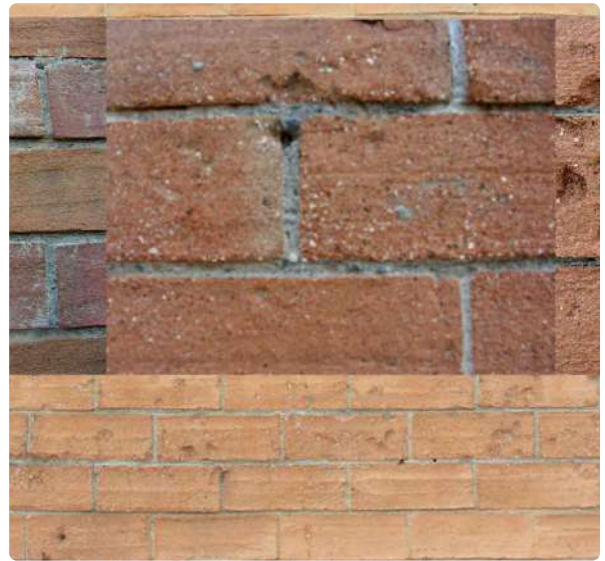
LADRILLOS METEORIZADOS POR ABSORCIÓN Y CONGELAMIENTO DEL AGUA (NO ESTÁN PROTEGIDOS).
