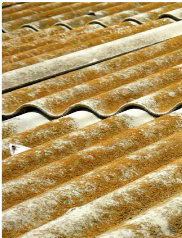
TECHO DE FIBROCEMENTO CON ALGAS DEBIDO A LA HUMEDAD RETENIDA POR POROSIDAD ORIGINADA POR CARBONATACIÓN, NO PINTABLE.
