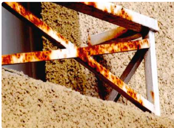
CORROSIÓN POR NIEBLA SALINA, AV. DEL MAR, LA SERENA.
